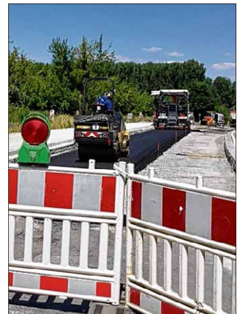
Der Knotenpunkt ist die Zugangsader und führt in den Industriepark. Foto: Stadt Calbe
